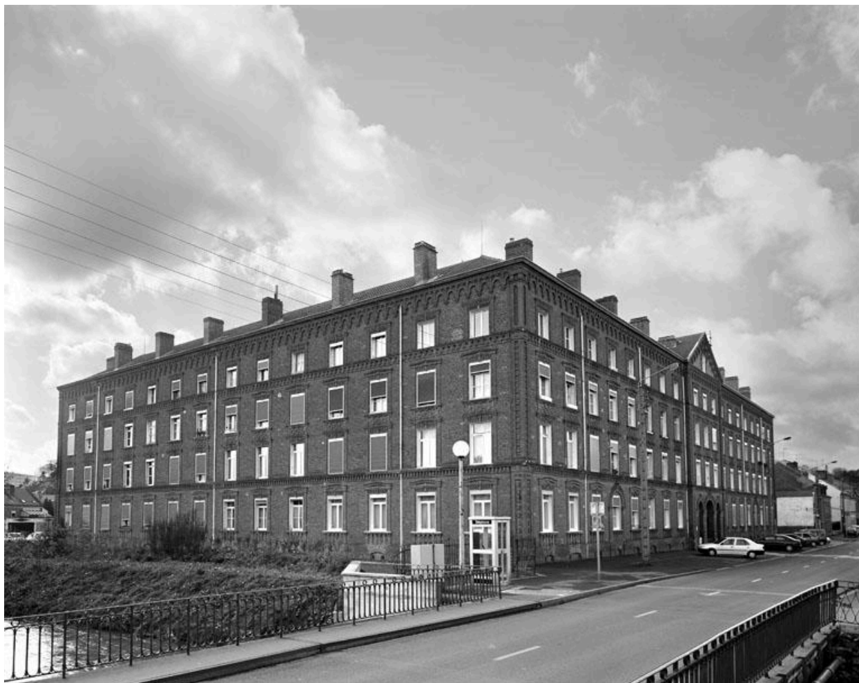
Vue des façades sur rue.
