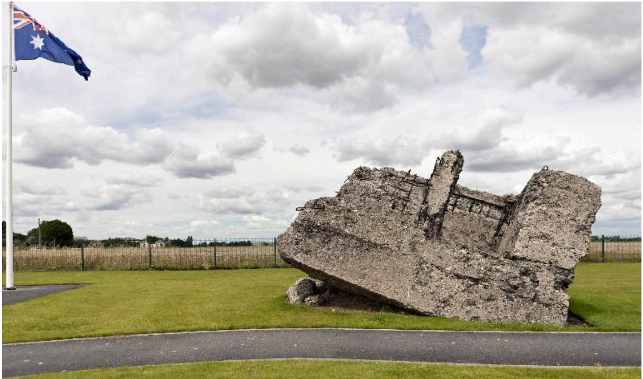
Vestiges de la casemate (e) retournée lors de l'explosion d'une mine, vers le nord
