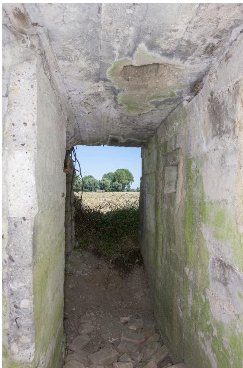
Intérieur du couloir de distribution, vers nord-ouest
