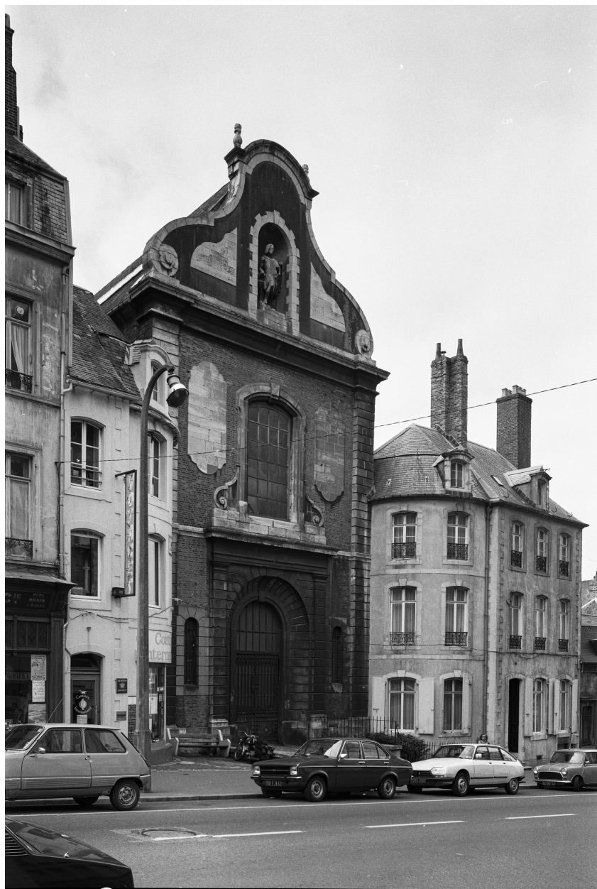
Chapelle, vue d'angle sur voie.
