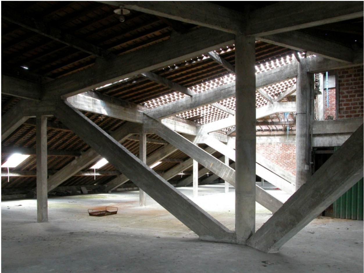
Ateliers des années 1946-48 : charpente en béton armé.
