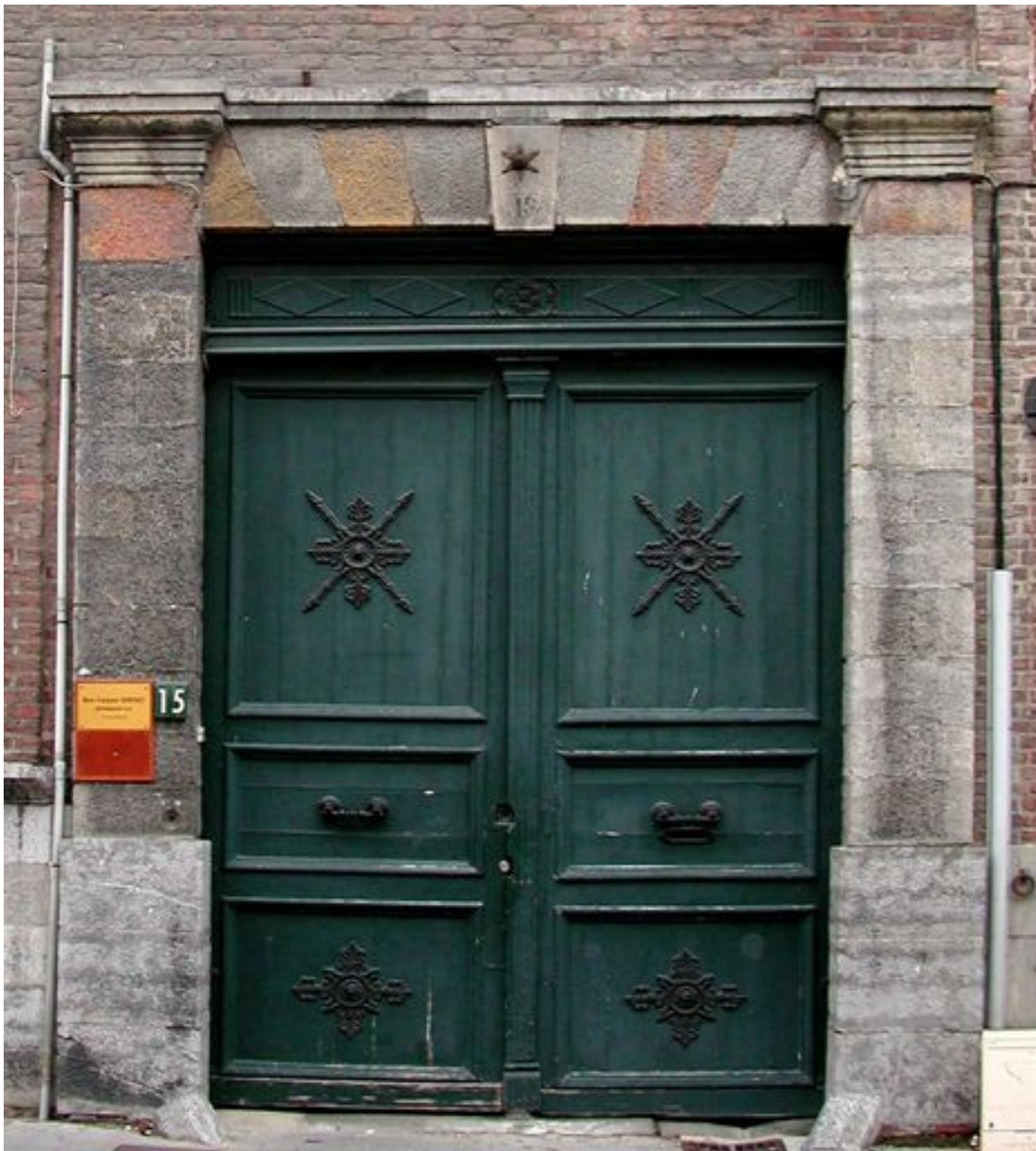
Façade, détail : porte cochère.
