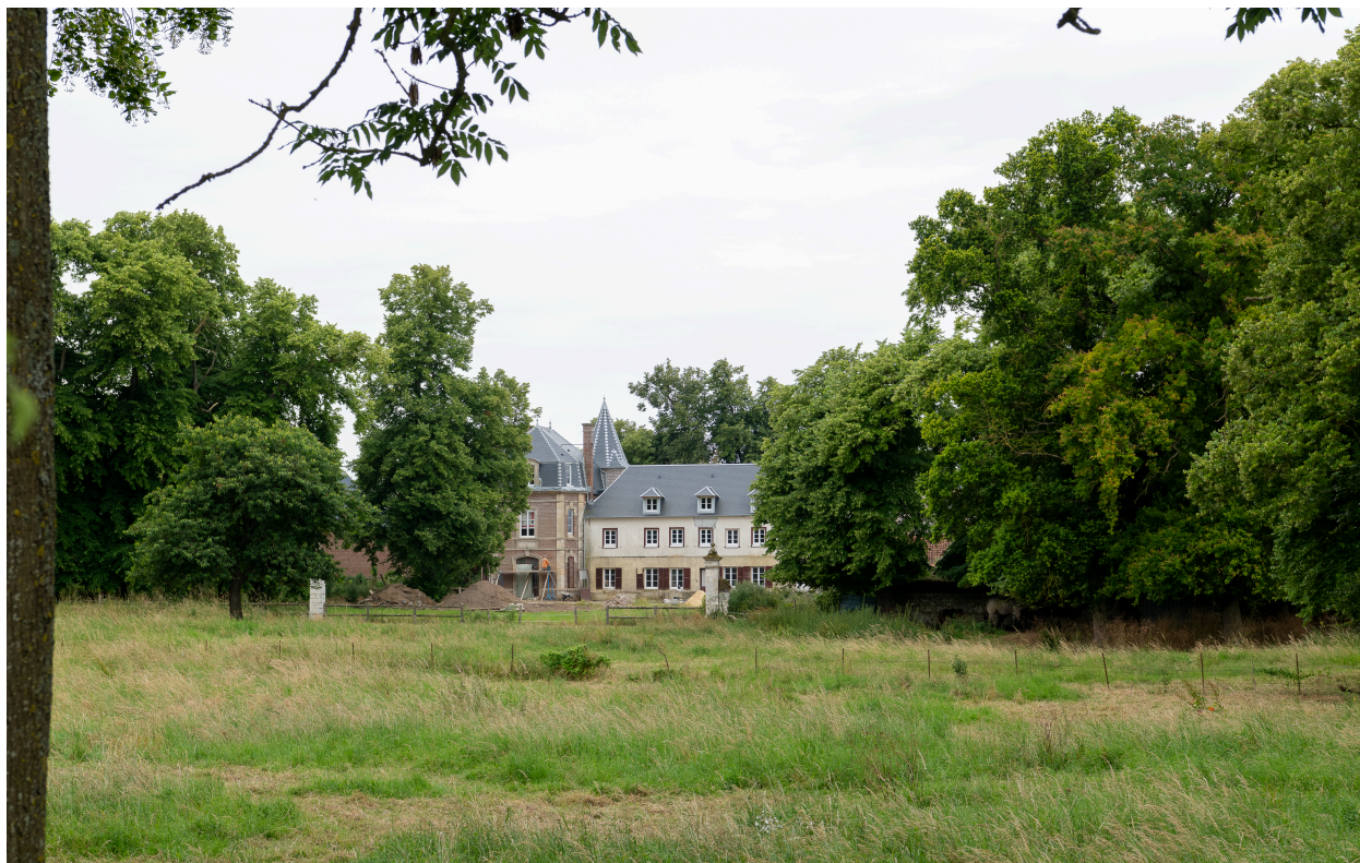
Vue du logis (en cours de restauration) côté parc depuis la route.
