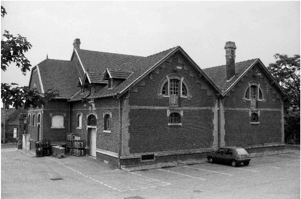
Magasin de commerce, élévation postérieure.
