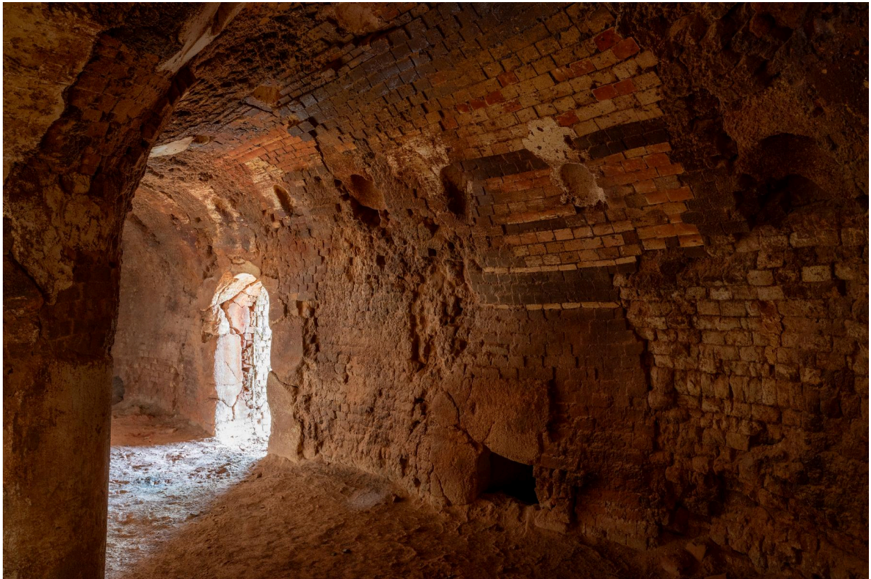
Four Hoffmann. Galerie de cuisson des briques.
