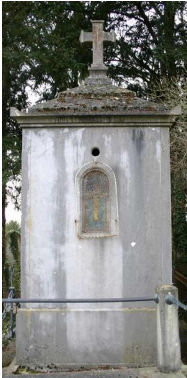
Vue rapprochée de la façade postérieure.
