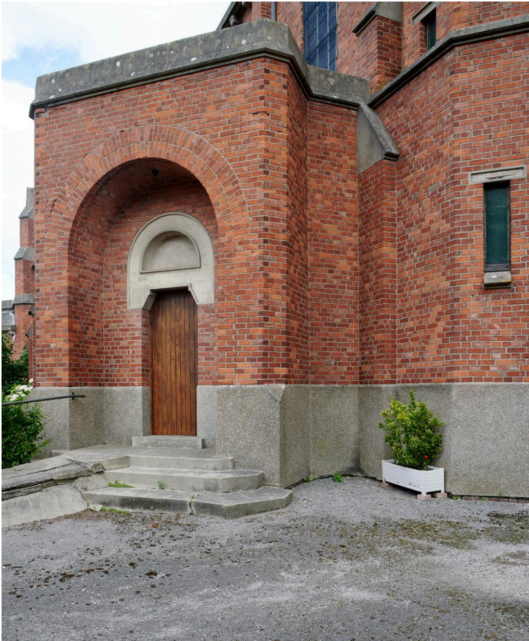
Portail d'entrée latéral sud de l'église.
