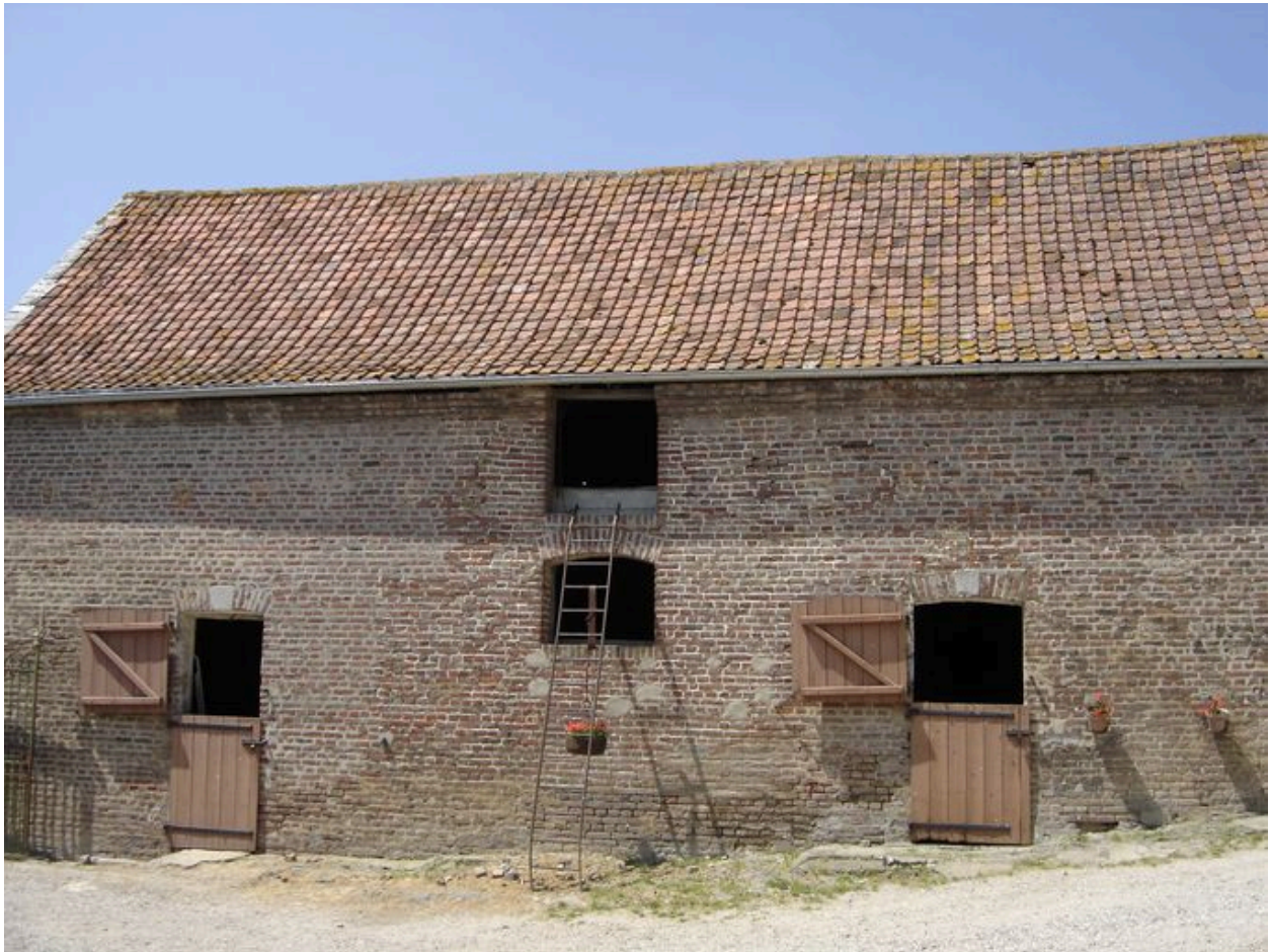
Vue de face des étables depuis la cour.
