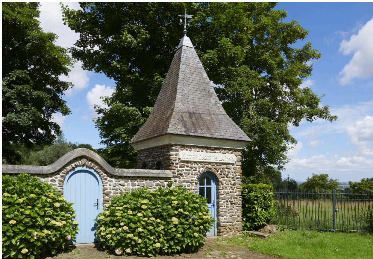
Vue depuis le nord-est. Chapelle, mur de clôture et portail.
