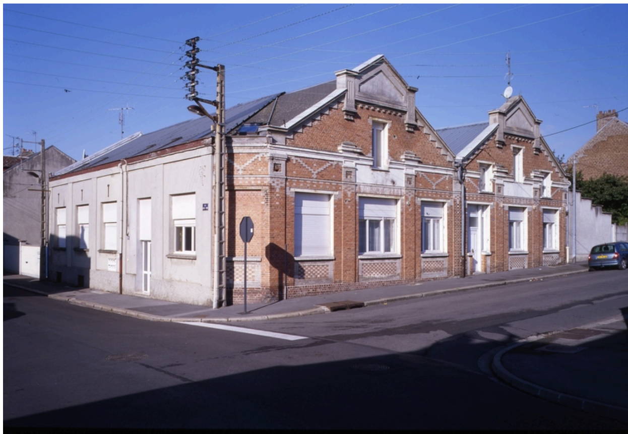
Les ateliers vus depuis le carrefour des rues Pierre-Ramus et Quentin-Barré.
