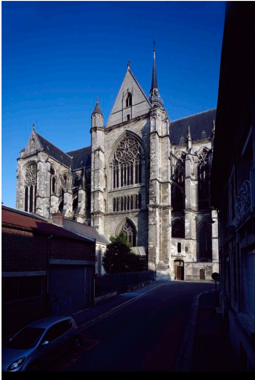
Vue de l'élévation nord du chœur.
