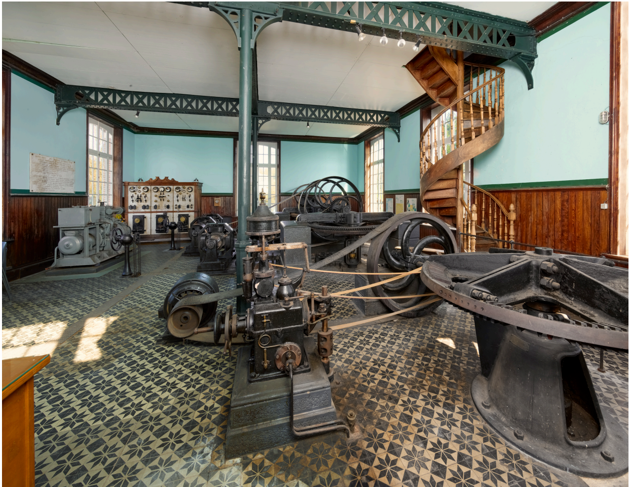
Intérieur, vue d'ensemble depuis l'entrée.
