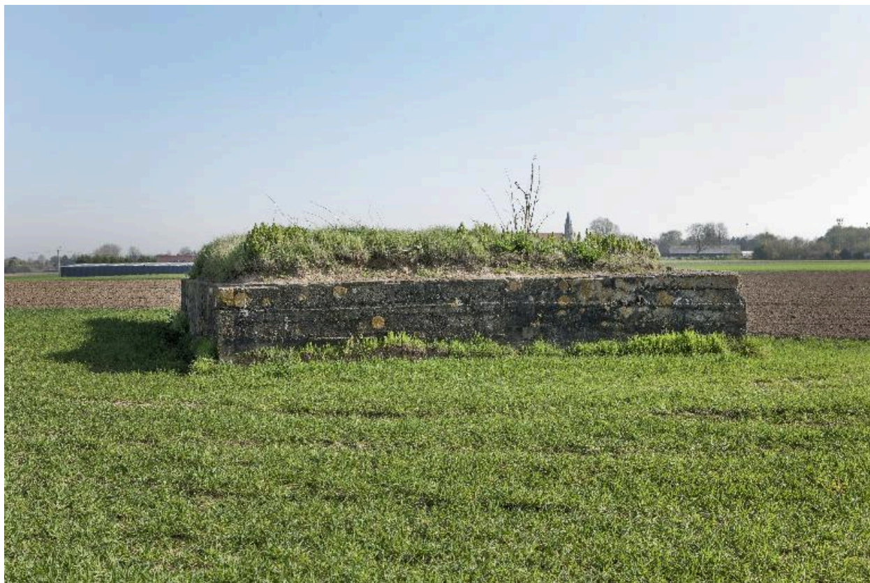
Vue générale vers le nord-est
