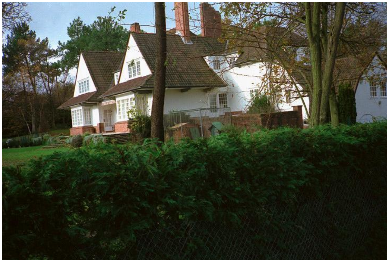
Vue d' ensemble latérale.
