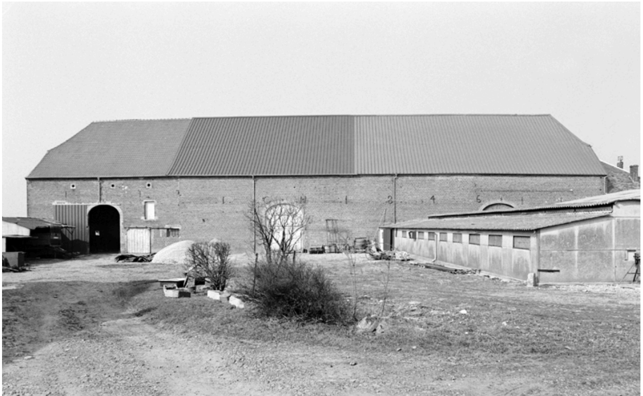
Façade de la grange.
