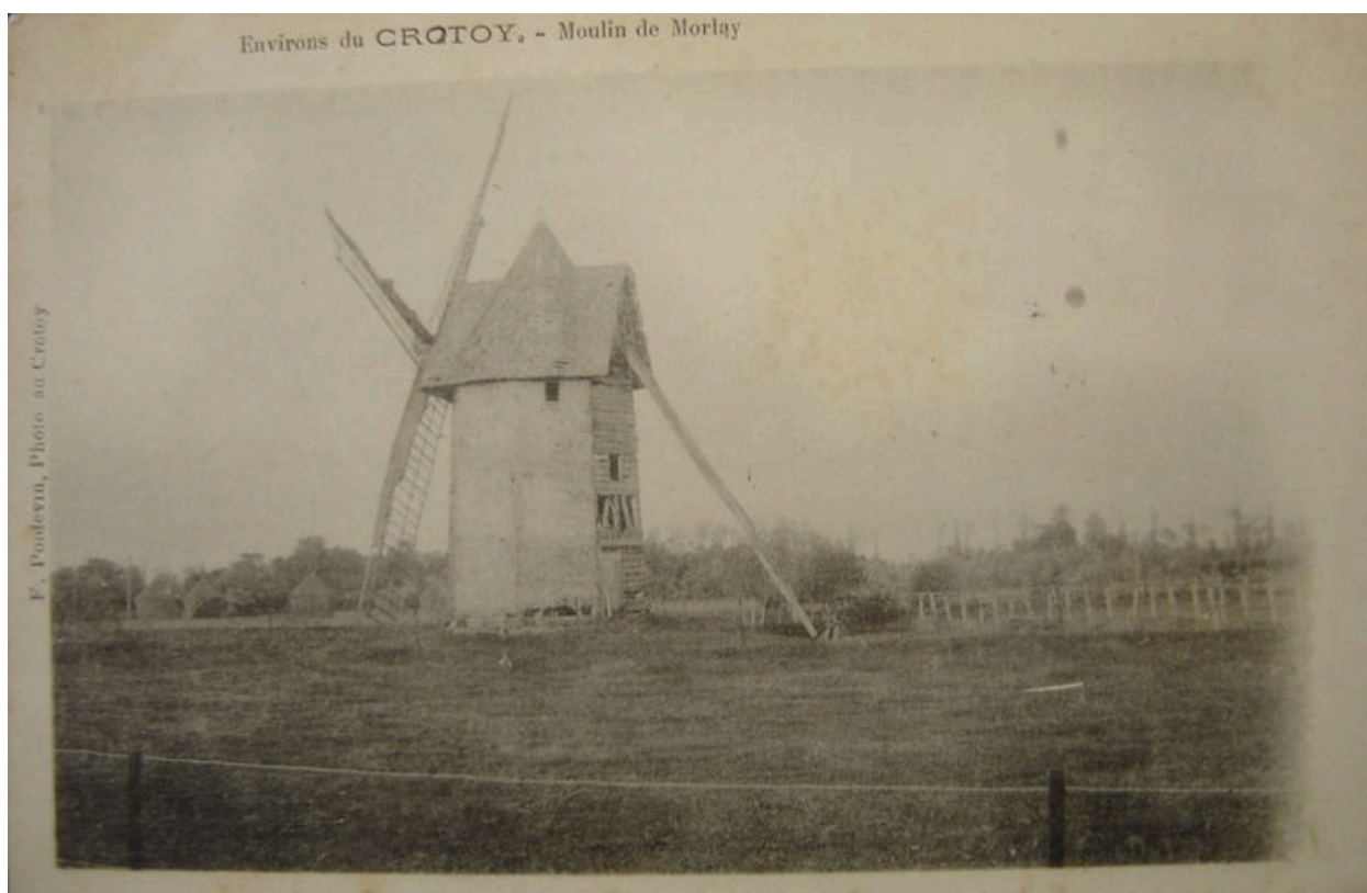
Vue du moulin à vent de Morlay au début du 20e siècle.
