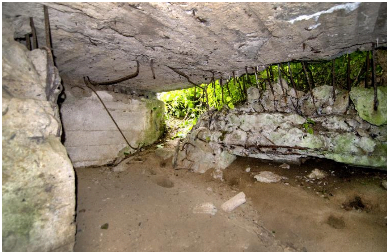
Vue intérieure vers la sortie sud-est
