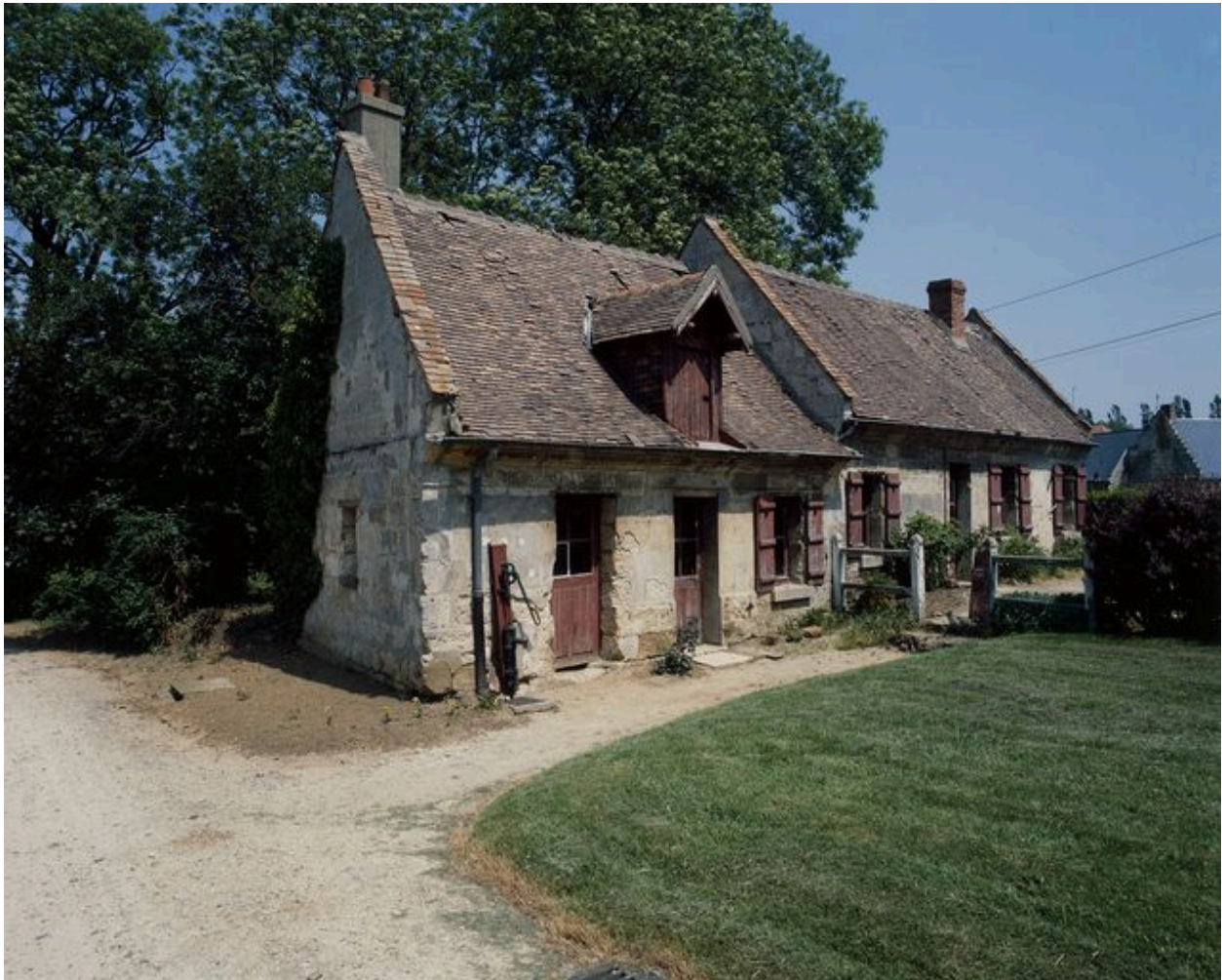
Logements de domestiques.
