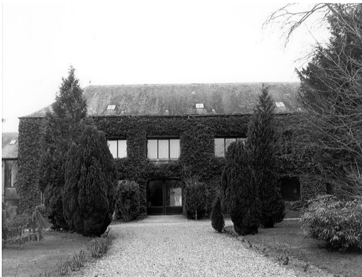
Vue d'ensemble de la façade sur cour.
