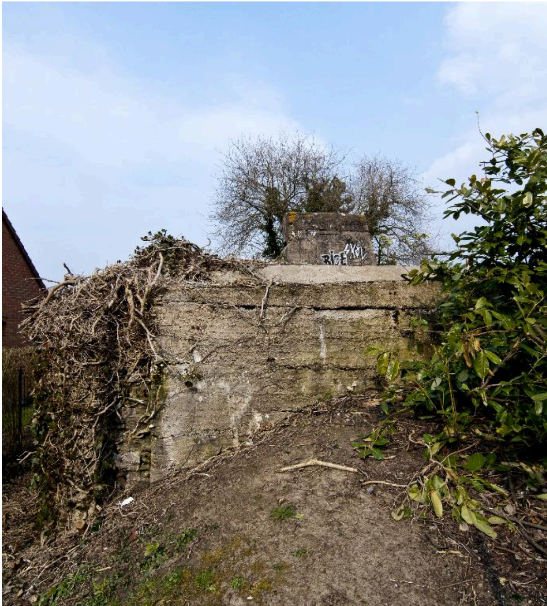
Vue vers le nord (au grand angulaire)
