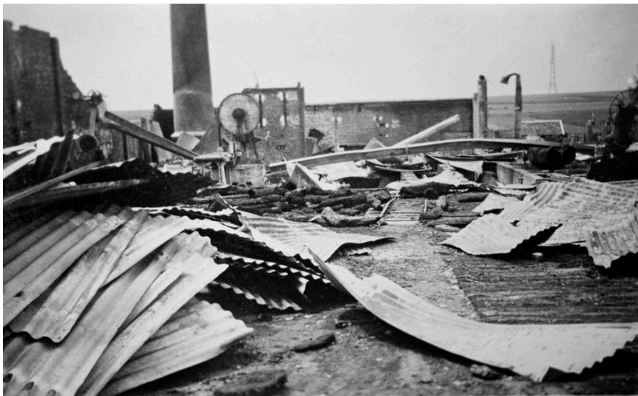
Etat des destructions après l'incendie de 1942 (AP).
