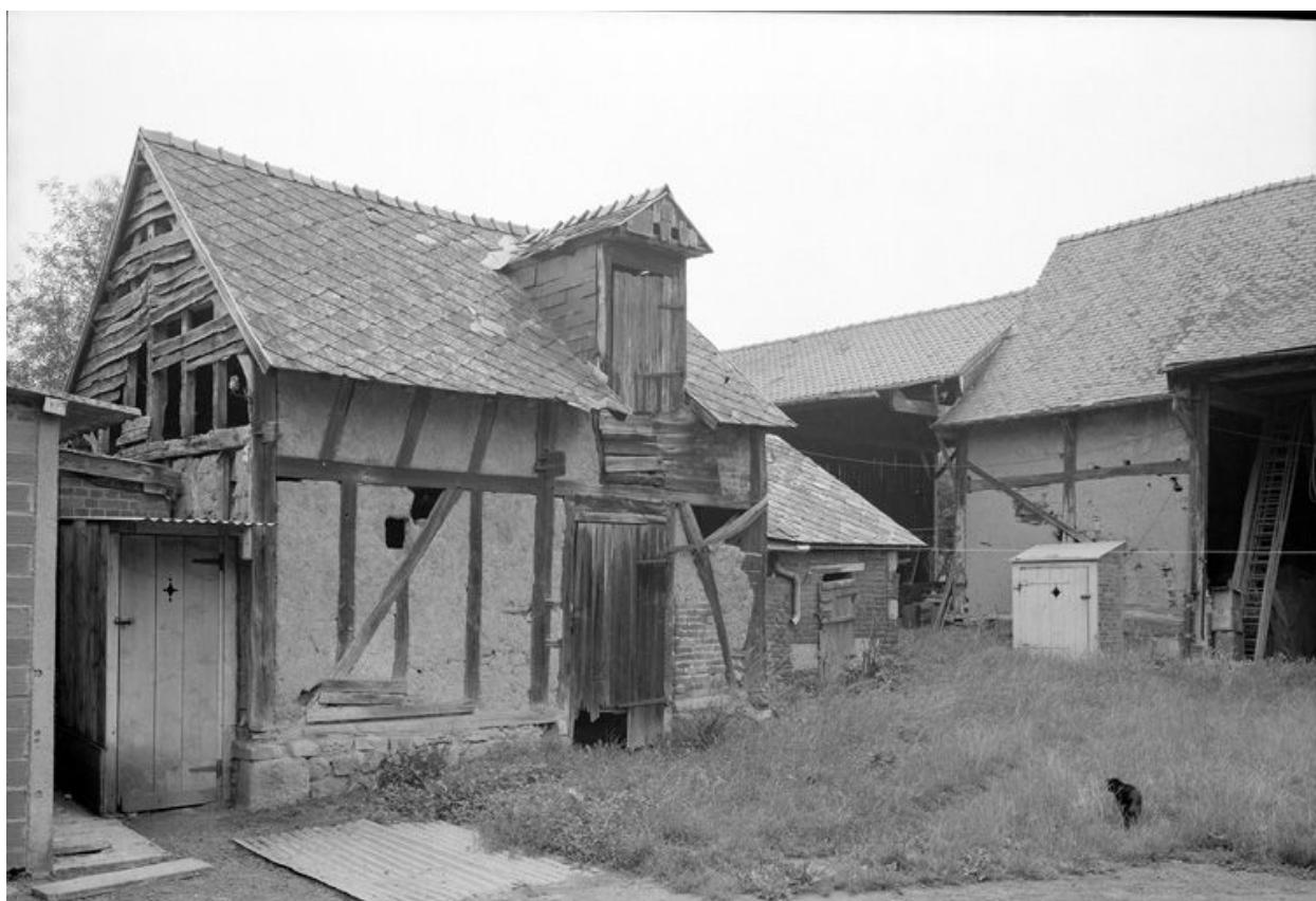
Bâtiments d'exploitation. Vue générale.
