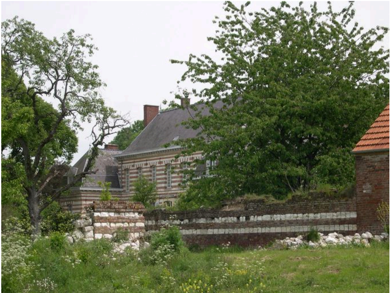
Vue de situation du logis abbatial et vestiges d'un mur de clôture.
