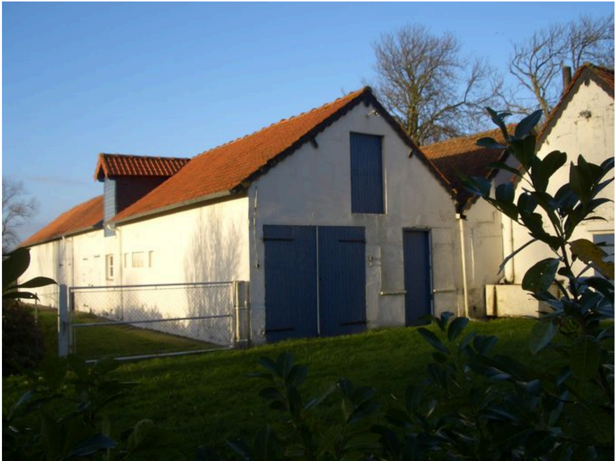
Vue postérieure des dépendances.
