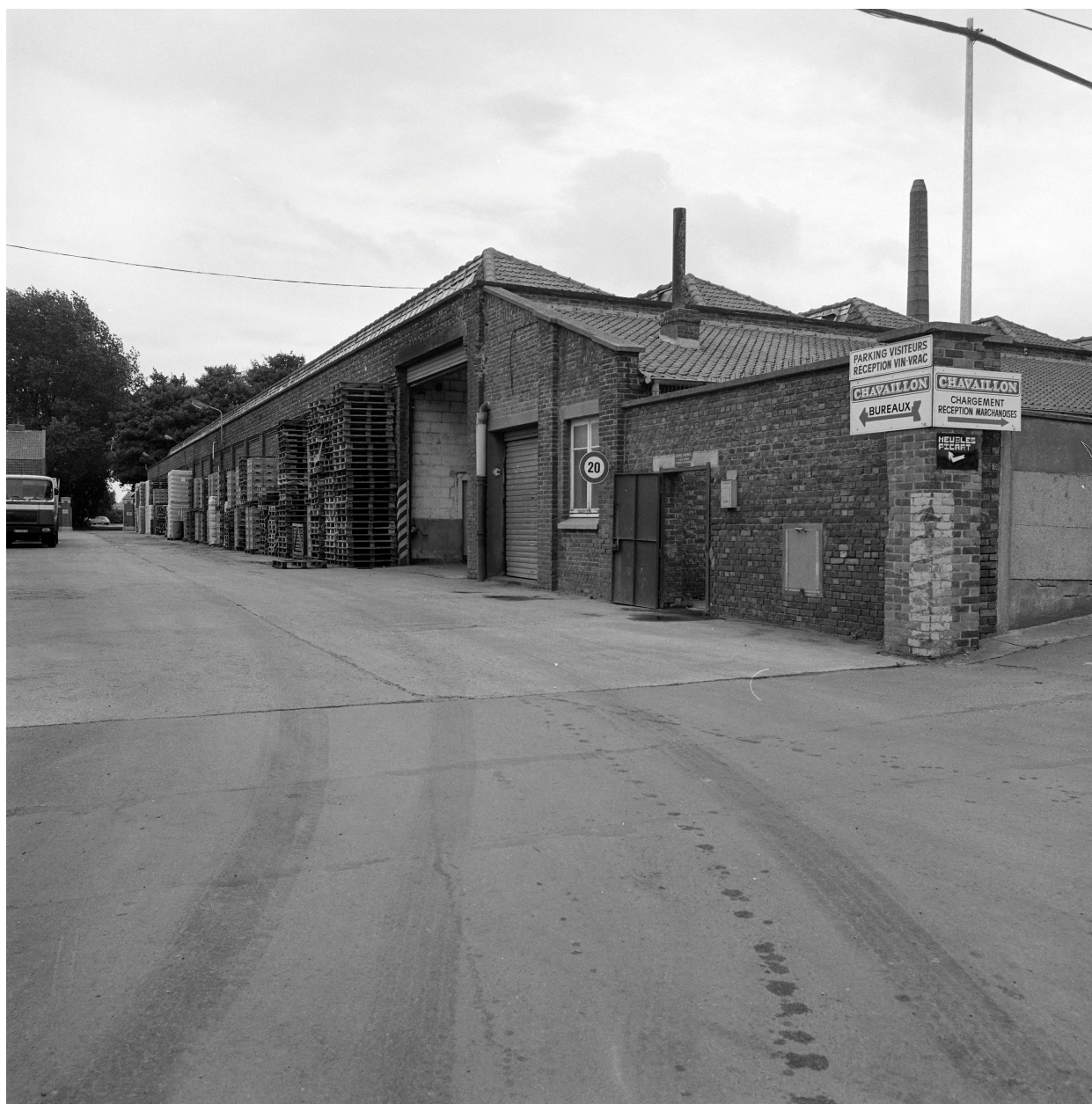
Atelier de fabrication, façade nord, vue générale.
