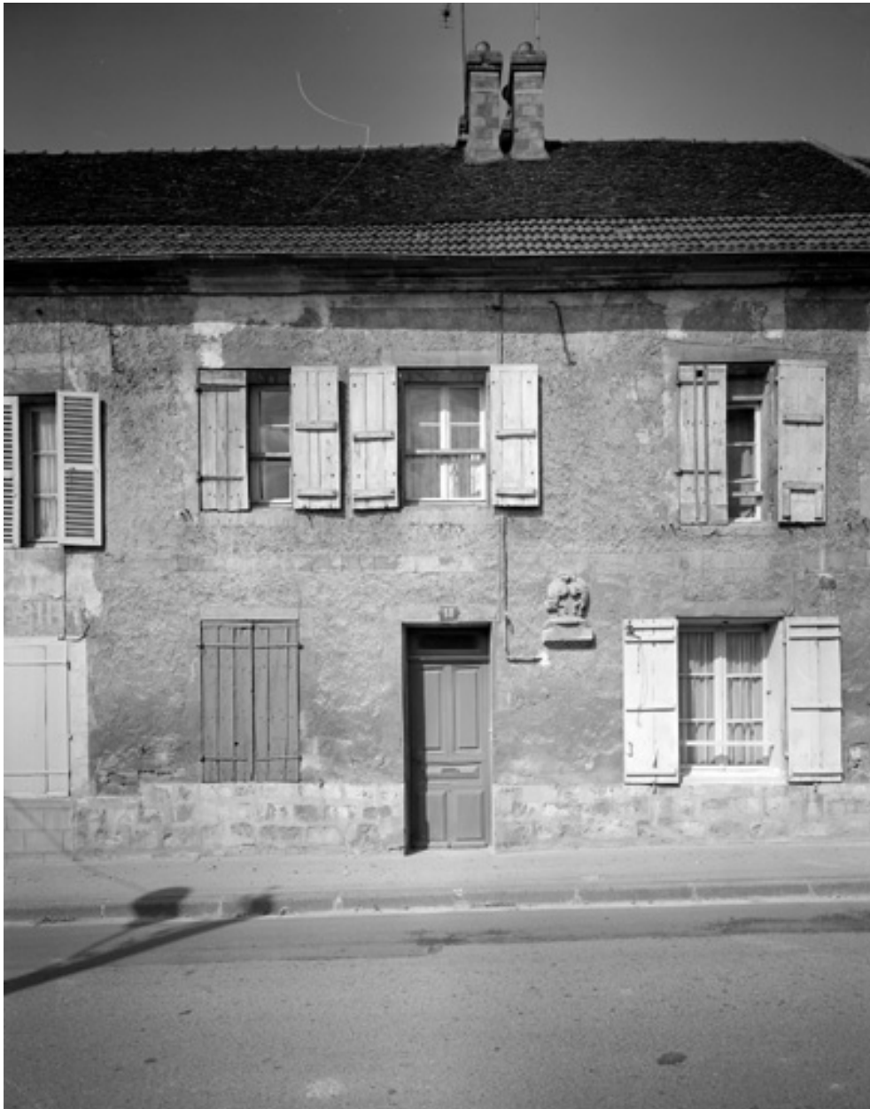
Détail de l'élévation sur la rue, avec le chapiteau en remploi.
