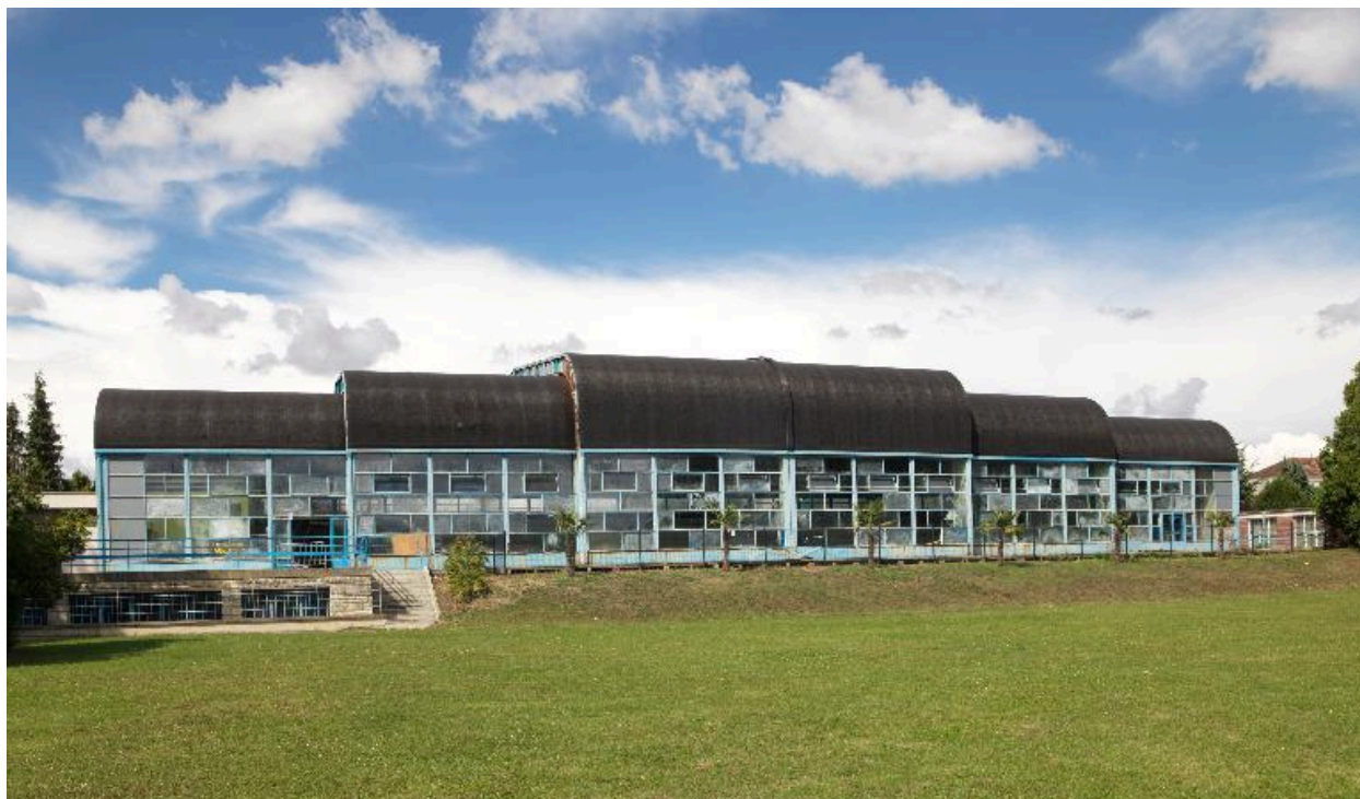
Noyon (Oise). La piscine Paul-Boutefeu construite sur les plans des architectes Claude Charpentier et Jean Tabanou et inaugurée en 1968.
