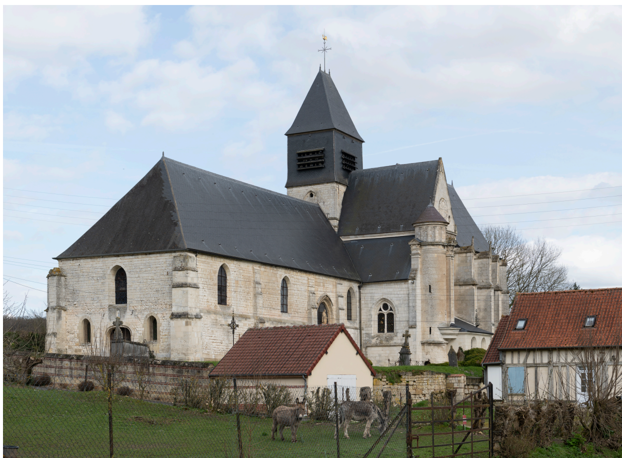
Vue prise depuis le sud-ouest.
