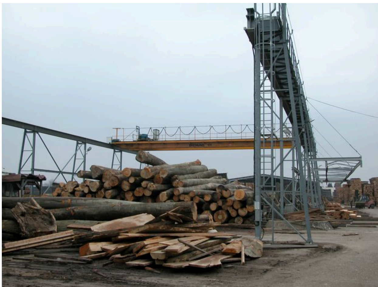
Aire de stockage des grumes, équipée d'un pont roulant.
