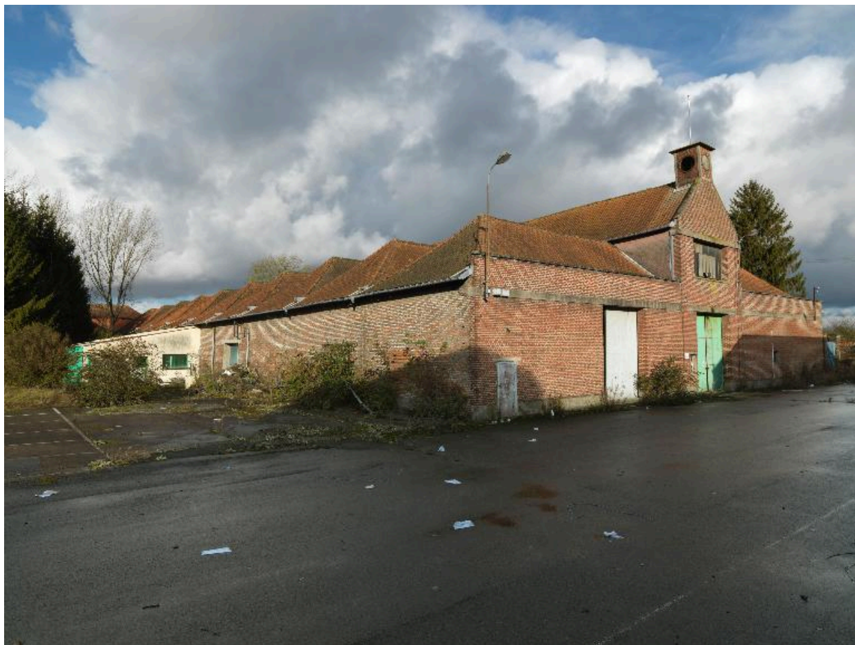
Les seconds entrepôts à jute, vue d'ensemble extérieure depuis l'ouest.
