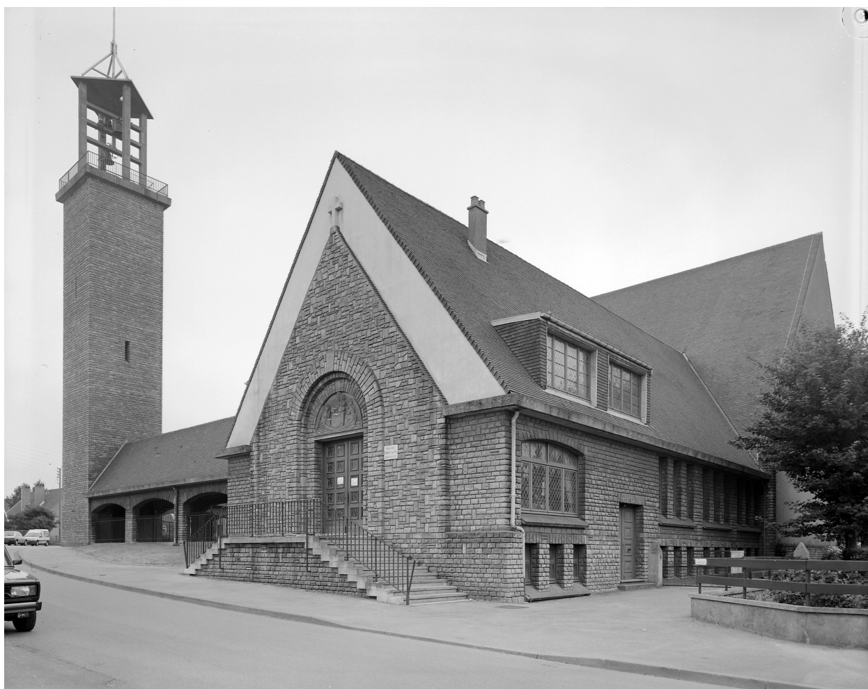
Vue d'angle sud sur rue de la Libération.
