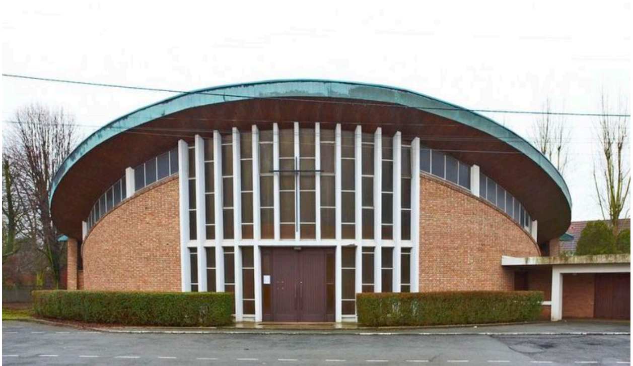
Vue de la façade.
