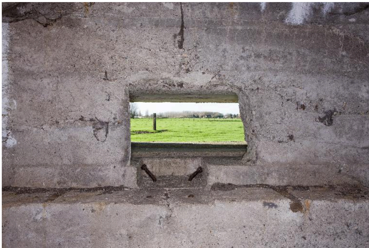
Casmate nord. Ouverture de tir ouest avec dispositif de blocage de la mitrailleuse.
