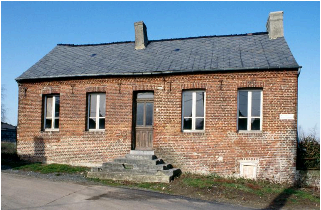
Vue d'ensemble de la façade.
