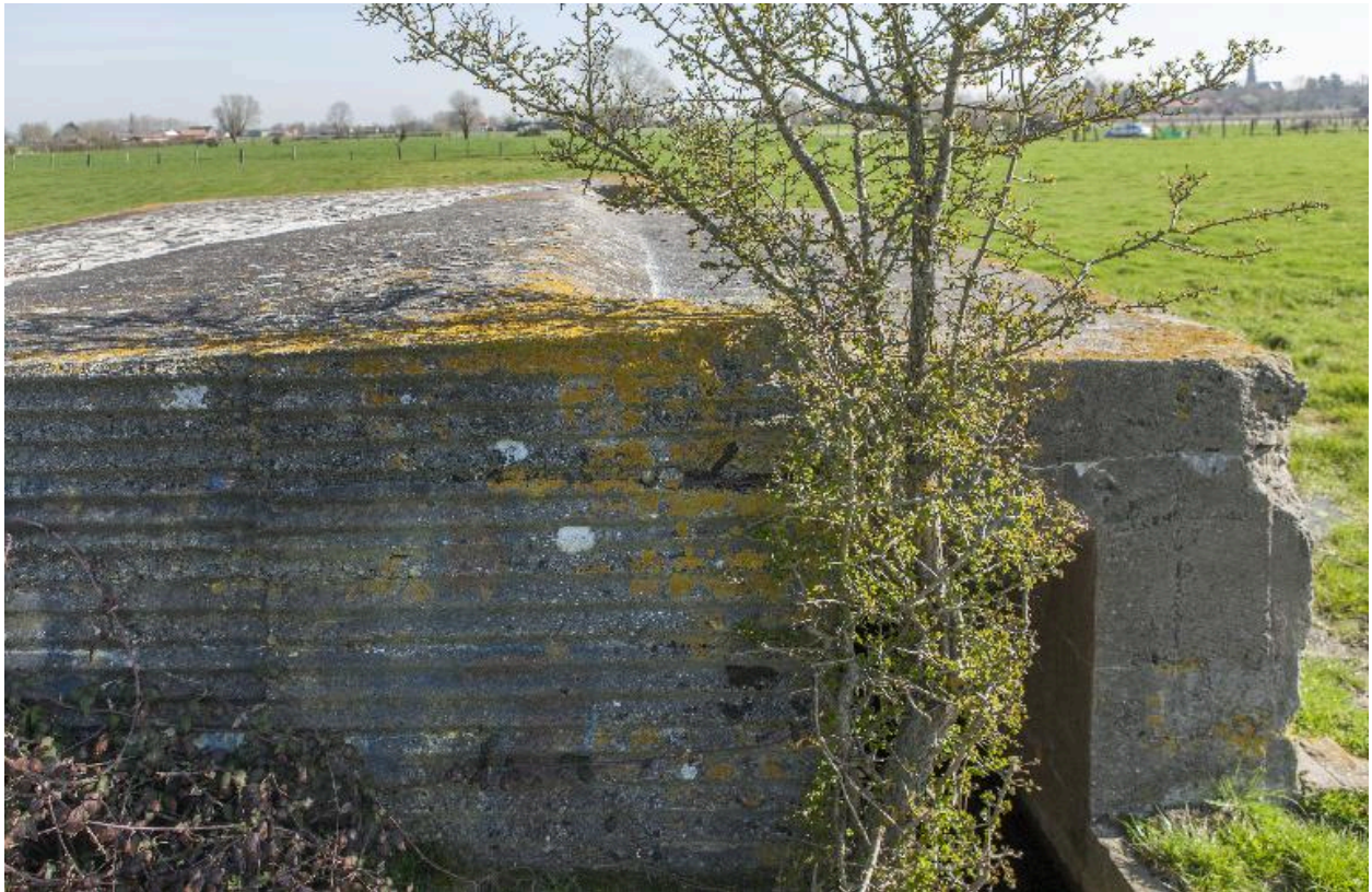
Vue latérale partiele, vers le nord-est avec le profil du couverture
