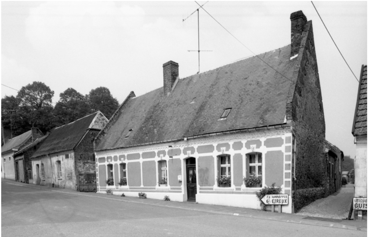
Vue d'ensemble du logis, depuis le sud.
