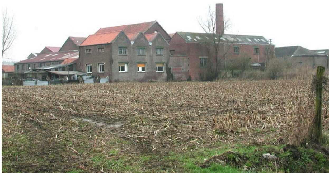
Vue générale arrière de l'usine.
