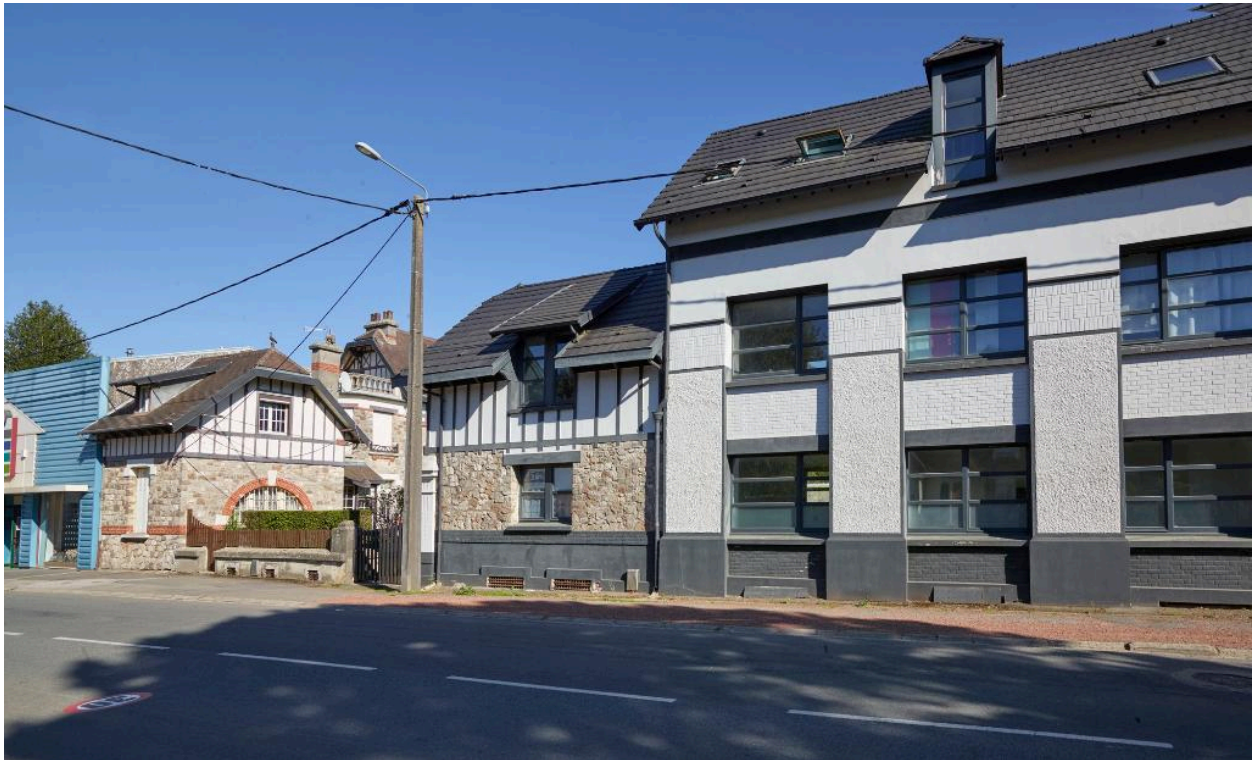
Articulation entre la scierie et la maison de maitre vue depuis la rue de Douai.
