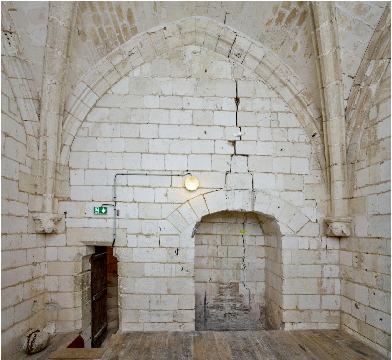
Intérieur de la salle des gardes du beffroi.
