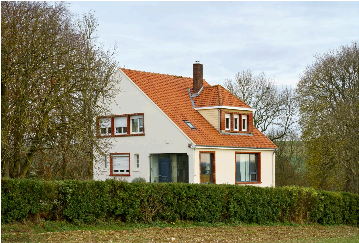
Maison, depuis le sud-ouest.
