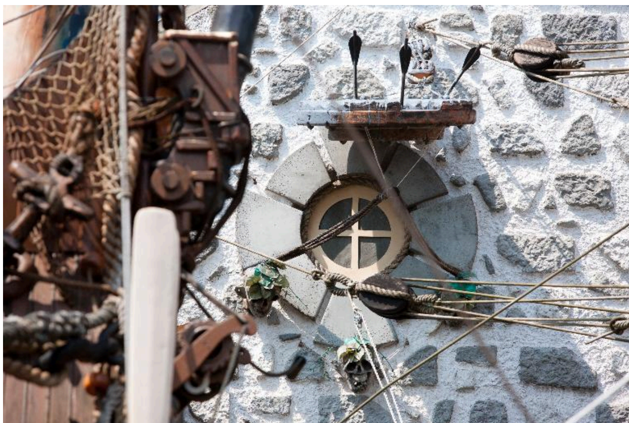
Vue partielle du pignon.
