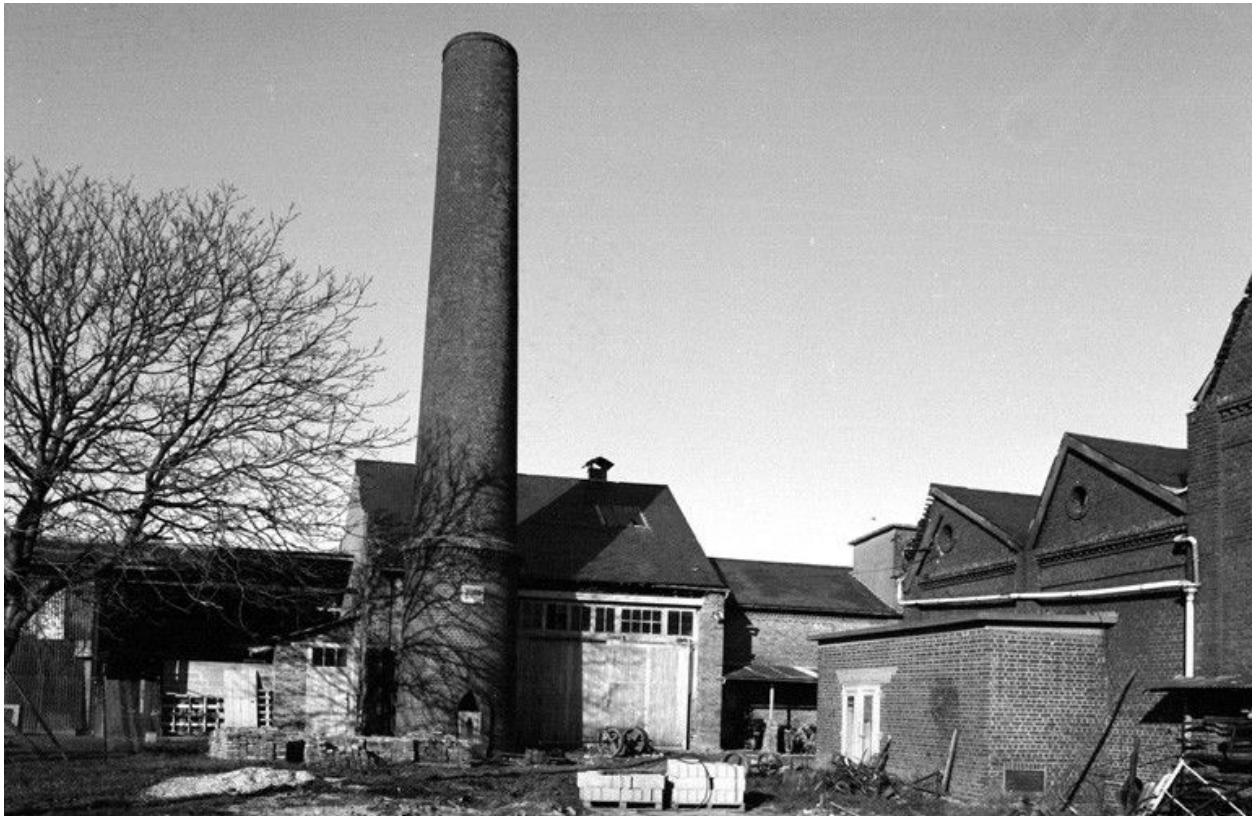
Vue partielle de l'usine, flanc sud.
