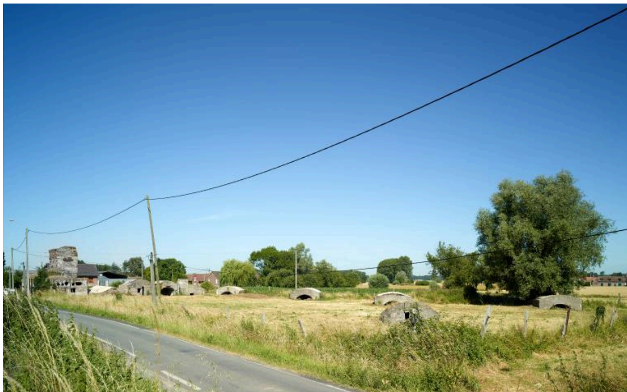
Vue générale, vers le nord-ouest.
