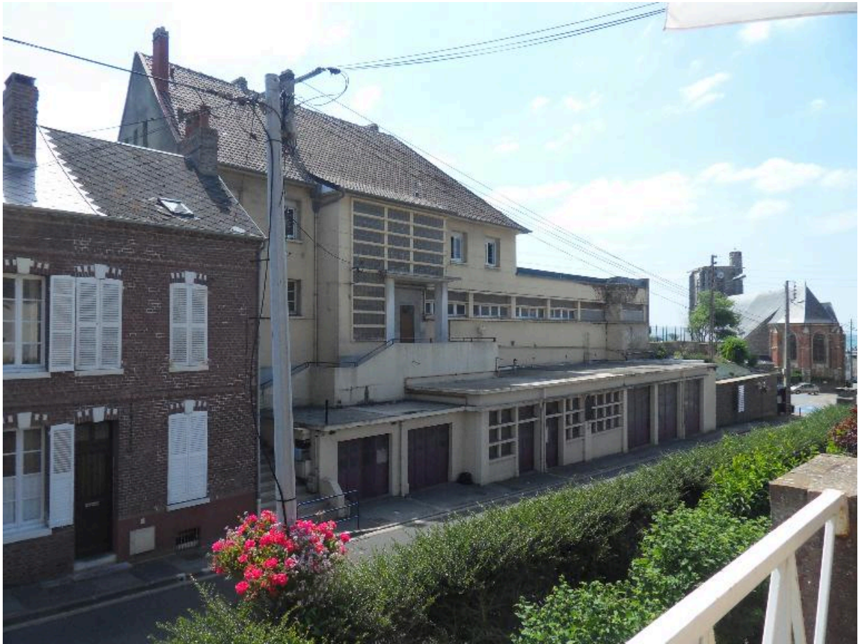
Vue générale depuis l'avenue du Général-Leclerc.
