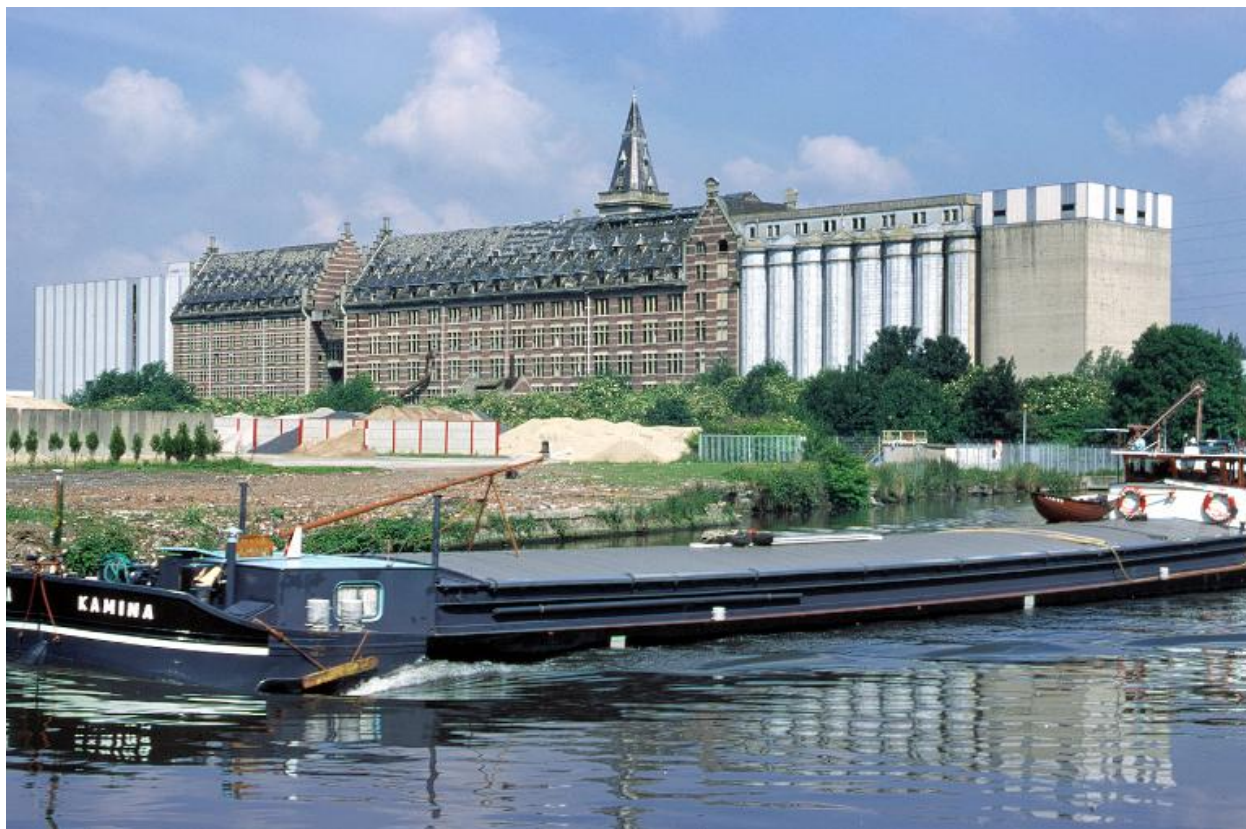
Vue générale vers le nord-ouest.
