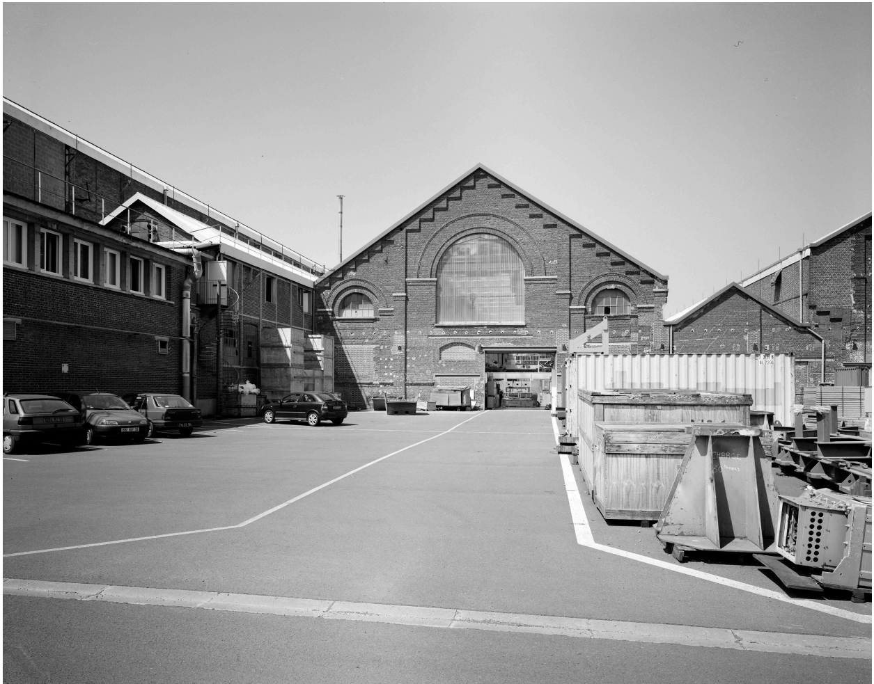
Élévation sud de la halle 7.
